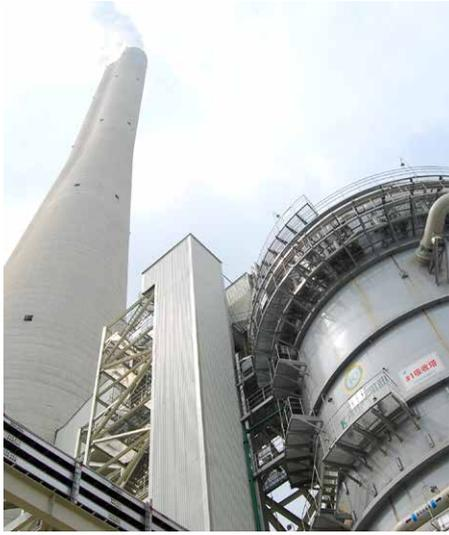
基于蒙特50多年来在气液分离领域积累的丰富经验，蒙特为华能长兴电厂“上大压小”2\*66万千瓦燃煤发电工程提供了新一代改进型高效除雾器解决方案。除雾器安装在湿法脱硫吸收塔内，用于拦截含有石膏和硫化物的液滴，防止其排放到大气中造成污染，实现出口剩余液滴含量 $20\text{mg}/\text{Nm}^3$ ，符合燃煤电厂烟气“超净排放”的要求。据浙江省环境监测中心在168小时试运行期
