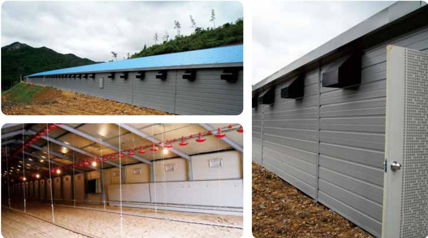
蒙特通风环控系统的核心是两款在业内饱受美誉的产品：CELdek® 蒸发冷却湿帘及Euroemme® 系列排风机。CELdek® 蒸发冷却湿帘可实现高效降温，适用范围广泛，且特别适用于家畜养殖场的室内降温。具有行业领导地位的Euroemme® 系列排风机因其高效节能、品质优异、密封绝佳的百叶窗设计及不会形成空气通道阻塞的离心式百叶窗开启系统等优势而颇负盛名。蒙特通风环控系统包括许多设备，可以为包括两极和赤道范围内所有环境下的家禽饲养提供理想的生长环境——如加热器可用于寒冷地区或寒冷季节，而且根据客户需求提供不同的设计或燃料需求；进风口可在低通风率的情况下实现均匀进风，且适用于各种建筑类型；适用于各种通风口的遮光罩可大幅降低室内的光强度，从而充分发挥人造日光的作用；风机/循环风机可使空气均匀性达到最优化，被加热的空气可均匀输送到每个角落，从而降低加热成本。控制系统可以集中控制所有设备，打造更智能、更适宜蛋鸡生长的室内环境。
