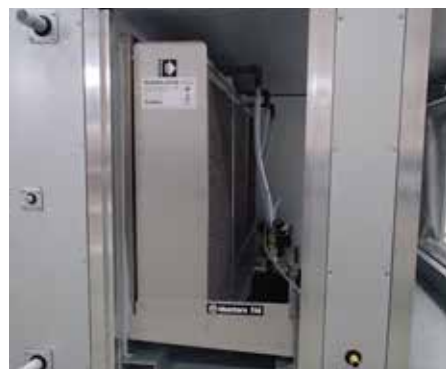
有关将 FA6 安装在空气处理设备功能段的示例
